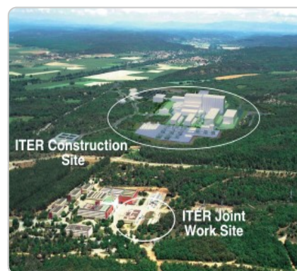
Cadarache (Francia del sud). L'estate scorsa sono iniziati i lavori per costruire "ITER" la prima centrale nucleare a fusione al mondo, quella che imiterà il ciclo delle stelle. Non ci saranno scorie radioattive da seppellire. L'impianto produrrà energia pulita ed illimitata dal 2040-50 (red)
